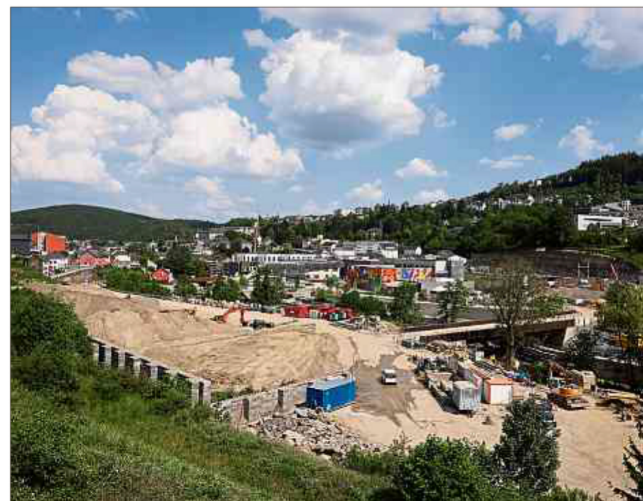
Diesen September soll das „Quartier Geetz“ nahe des Schulkomplexes und des Bahnhofs – in dieser Ansicht auf dem gegenüberliegenden Flussufer – eingeweiht werden.
