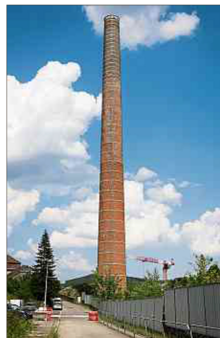
Der Industriekamin der früheren „Ideal“-Fabrik soll zwischen modernen Häusern und Natur bestehen bleiben.
