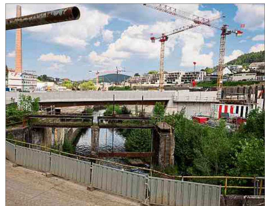
Der noch von Baustellen umgebene renaturierte Flusslauf vermittelt eine erste Idee davon, wie grün die Wohnviertel werden sollen.
