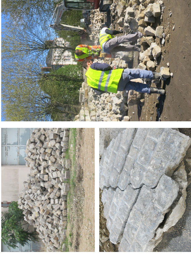
ZAC Caserne Mellinet, Nantes. Le type de pose et de mortier influe fortement sur la démontabilité
