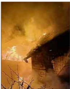
Das Haus ist durch die Brandschäden vorerst unbewohnbar.
