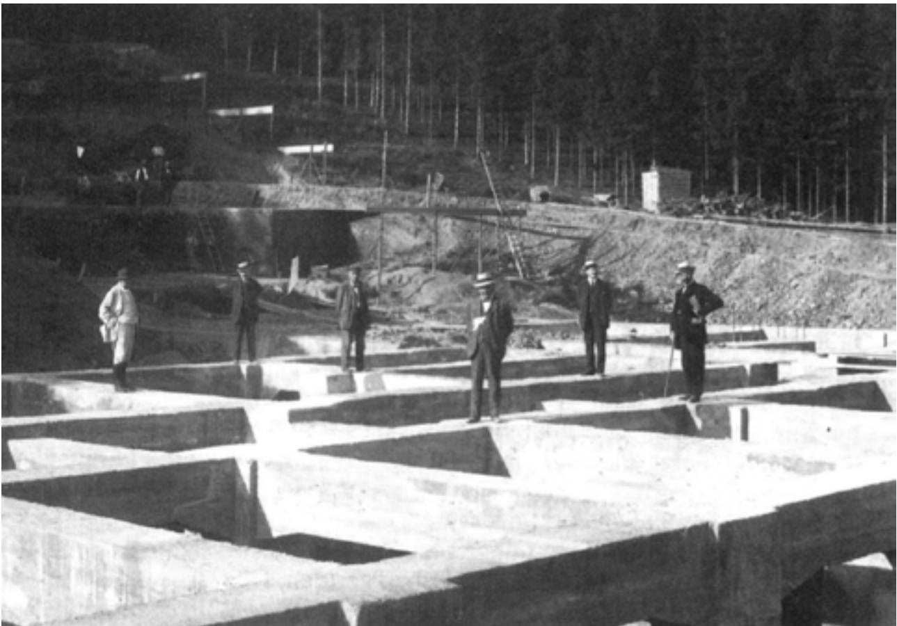
Erdarbeiten für das Sanatorium
