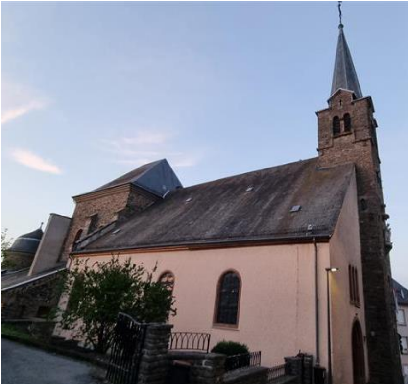
Abbildung 14: Blick von Süden auf die „Eglise Notre-Dame Wiltz“.
