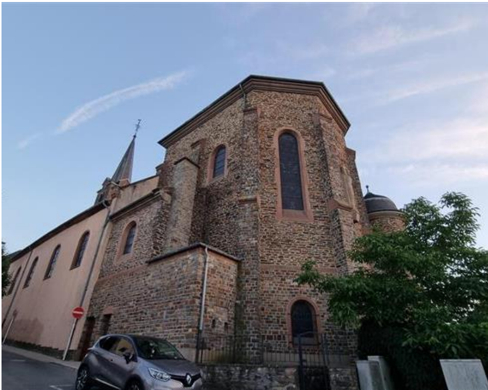
Abbildung 13: Blick von Norden auf die „Eglise Notre-Dame Wiltz“.
